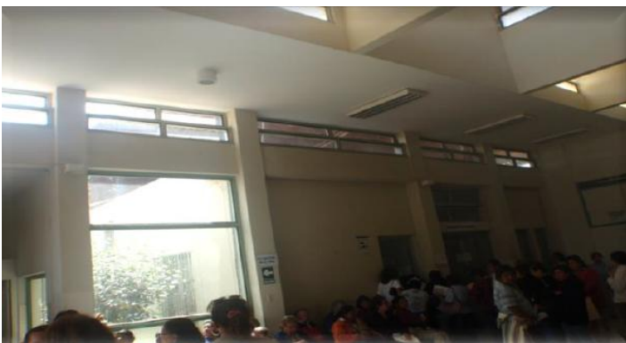
Ilustración 3 Se aprecia la irregularidad en altura donde el techo de la parte central del hall está a mas altura que la edificaciones vecinas convirtiéndose en crítica ante la amenaza de un sismo por la presencia de columna corta.
