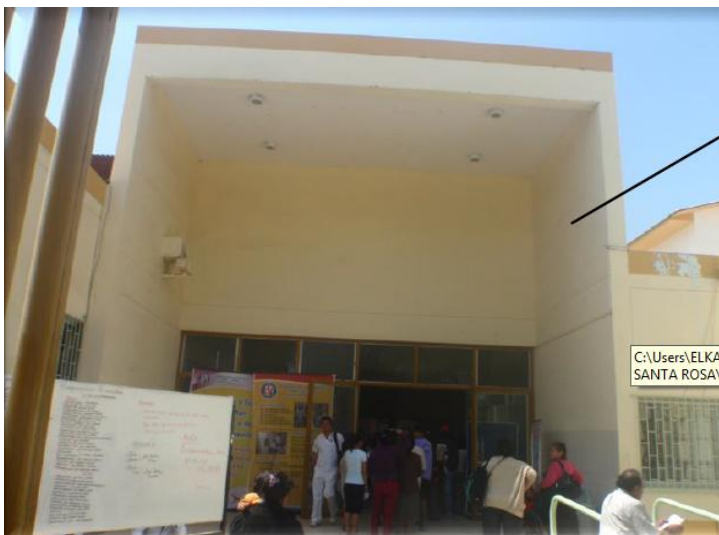
Ilustración 7 Se observa irregularidad en elevación que genera columna corta con los bloques de los costados
