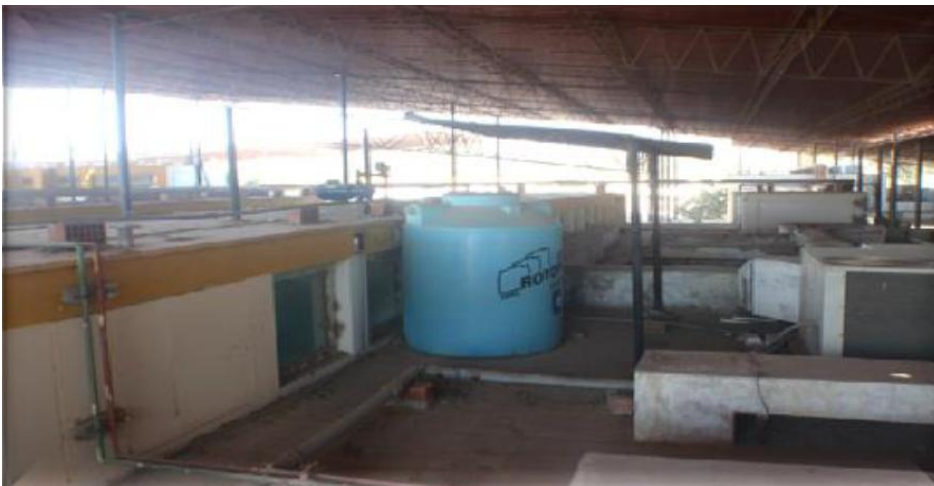
Ilustración 13 Se observa un tanque de agua dura que alimenta a la central de esterilización generándoles problemas porque no se ablanda.
