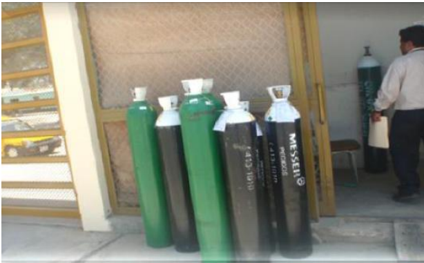
Ilustración 15 El depósito de gases medicinales totalmente inseguros y sin sujeción pudiendo causar serias lesiones especialmente a los usuarios del servicio de emergencia.
