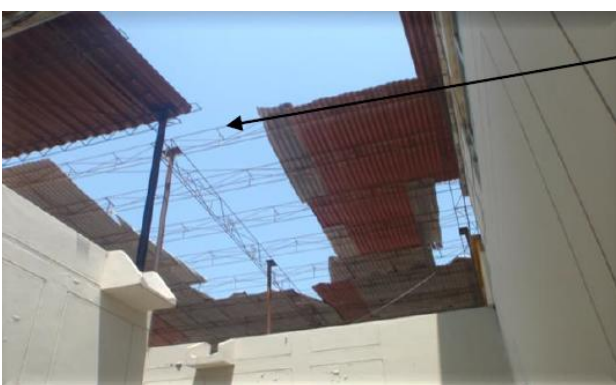
Ilustración 4 Se aprecia la cobertura de PVC deteriorado por acción del viento y calor. Requiere tomar acciones inmediatas.
