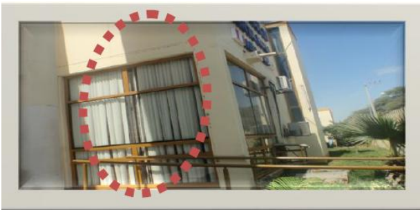
Ilustración 6 Ventanas del módulo con vidrios simples y crudos.
