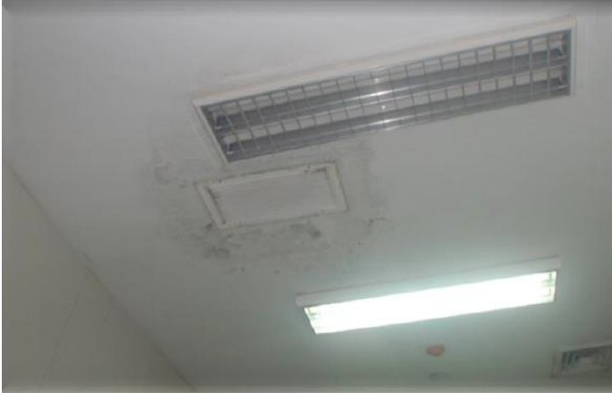
Ilustración 5 Se aprecia presencia de humedad en los techos por problemas en los equipos de aire acondicionado
