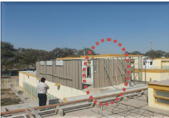
Ilustración 12 Se observa la construcción de aulas sobre el techo de consultorios externos, sobrecargándolo y modificando el comportamiento estructural.
