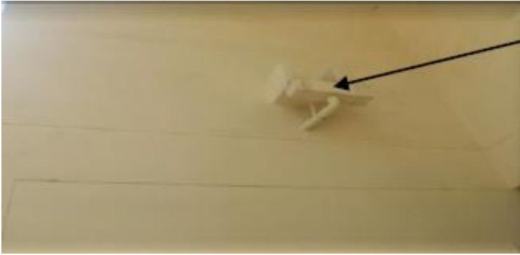
Ilustración 8 Se observa drenaje fluvial dentro del hall de ingreso a los consultorios
