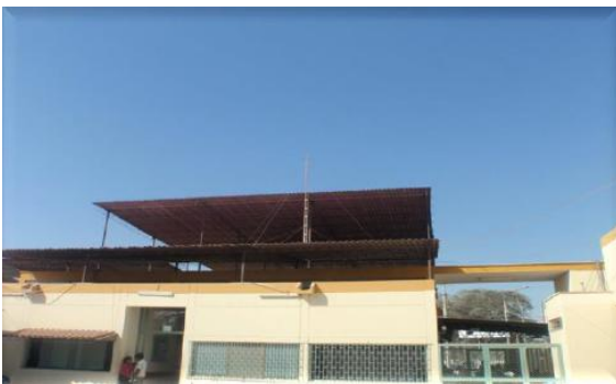
Ilustración 16 Se observa el ambiente de emergencia cuya cobertura de estructura metálica protege de las lluvias.
