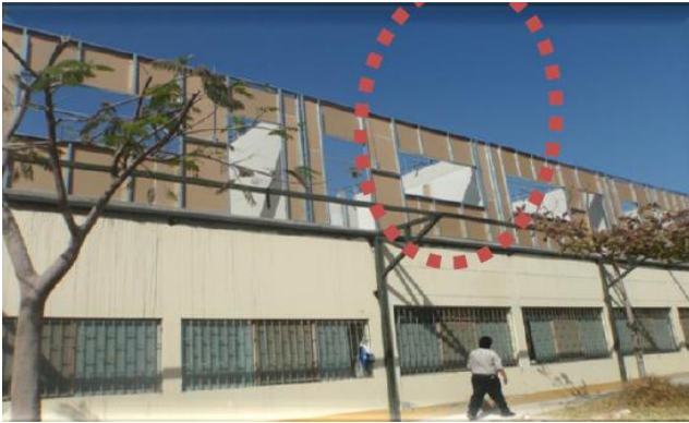
Ilustración 11 Se observa la construcción de aulas sobre la sala de hospitalización con material pre fabricado. Sobrecargando el techo modificando el comportamiento estructural.
